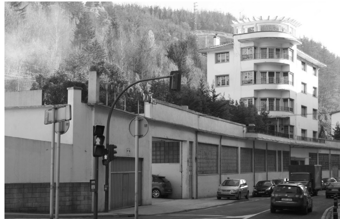
5.4- Gabilondo eraikinaren kanpoaldeko bista. 5.4- Vista exterior del edificio Gabilondo.
