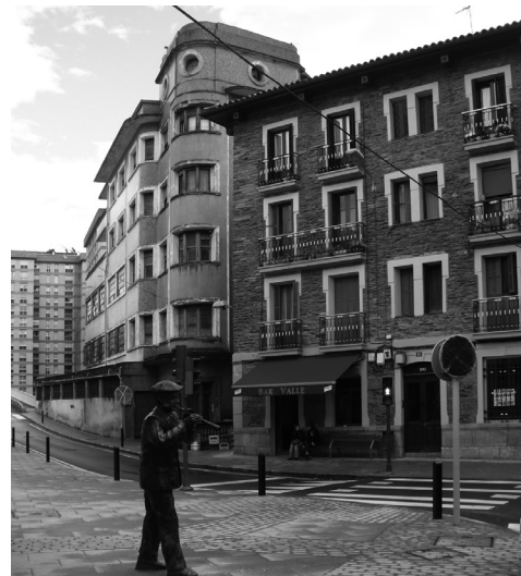
3.2- Eraikinaren kanpoladeko bista. 3.2- Vista exterior del edificio.
