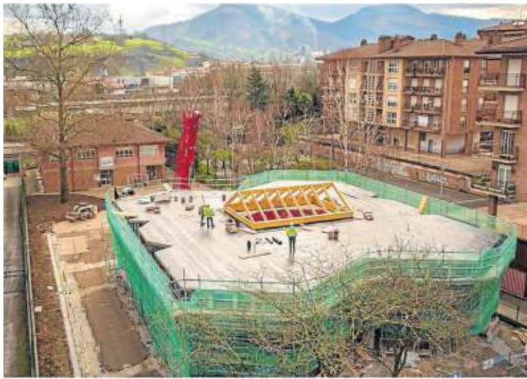
Obras de la recién renovada Emakumeen Etxea de Hernani. Foto: Bira Produksioak
